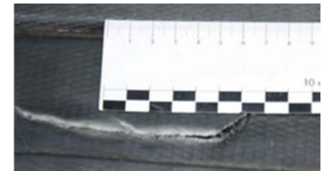
Luknje v trdih plastičnih oblogah. Popravilo trdih plastičnih oblog – fiksna tarifa za 1 uro dela, če je popravilo mogoče in se lahko zagotovi estetsko sprejemljiv rezultat
